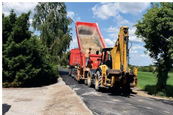
Budowa drogi w Młodocinie
