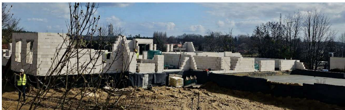
Gminna Baza Bezpieczeństwa w budowie
