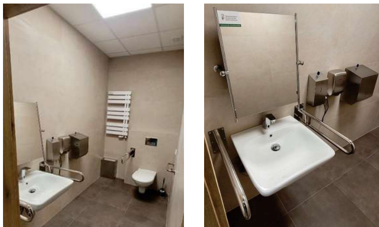
Przebudowany węzeł w budynku ZS
