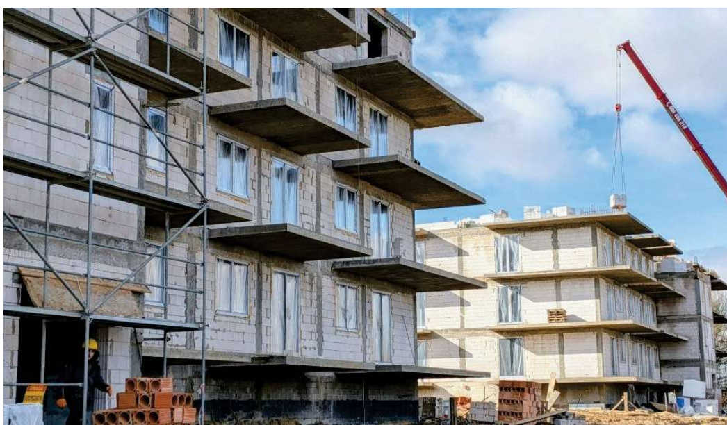
Budowa bloków w Krotoszynie
