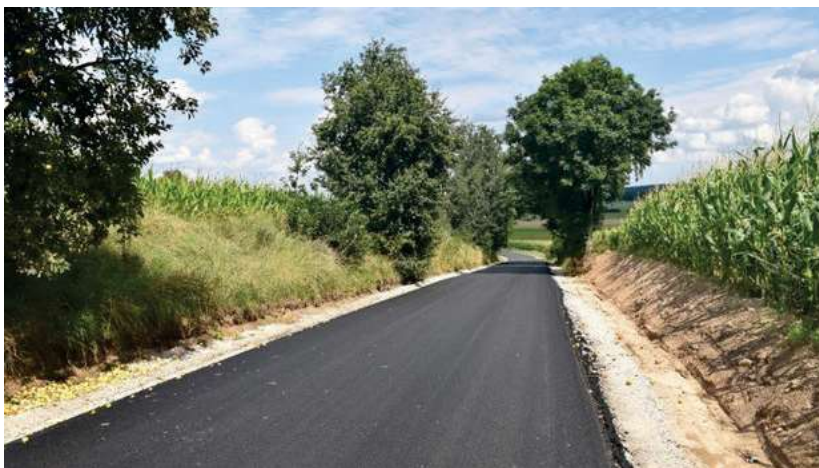
Droga powiatowa Młodocin – Kierzkowo po modernizacji
