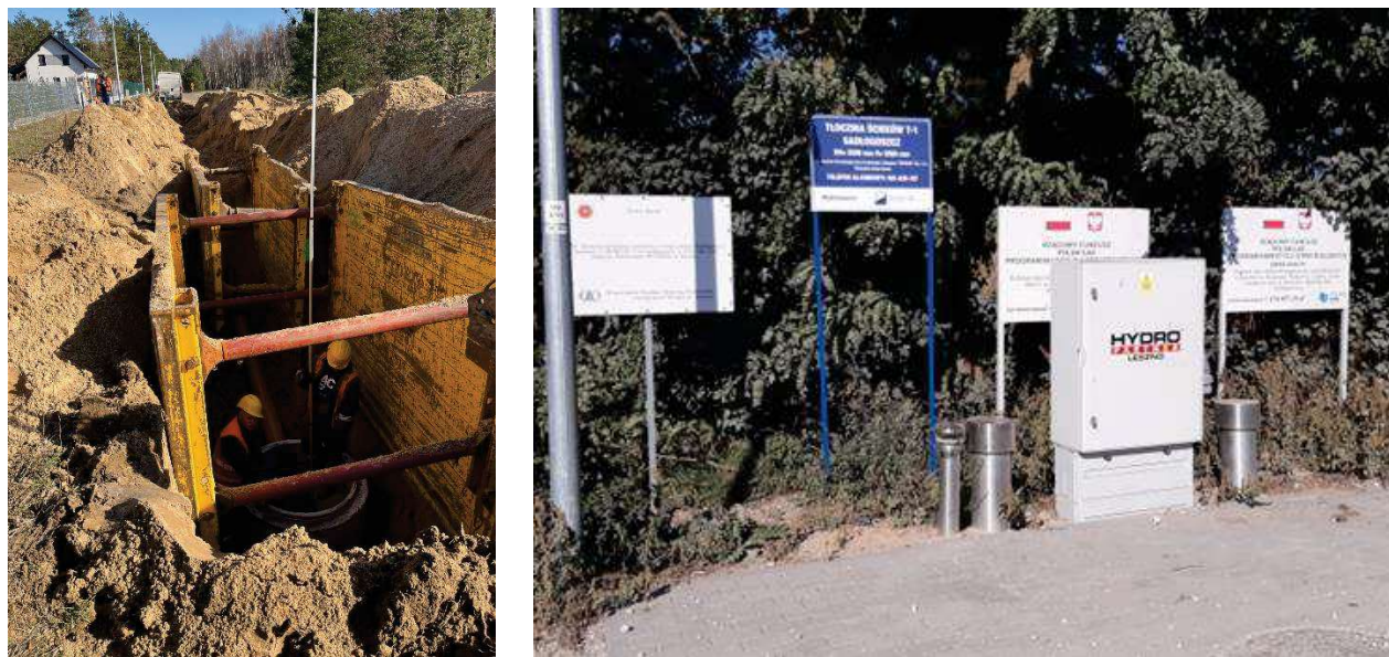
Kanalizacja w Sadłogoszczy - budowa
