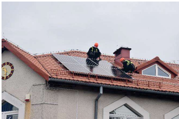
Montaż fotowoltaiki na dachu Urzędu
