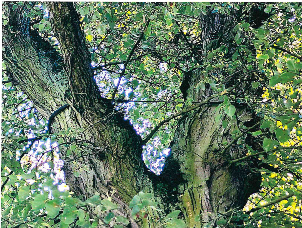
Wiązanie statyczne z liny stalowej na wysokości ok.7m
