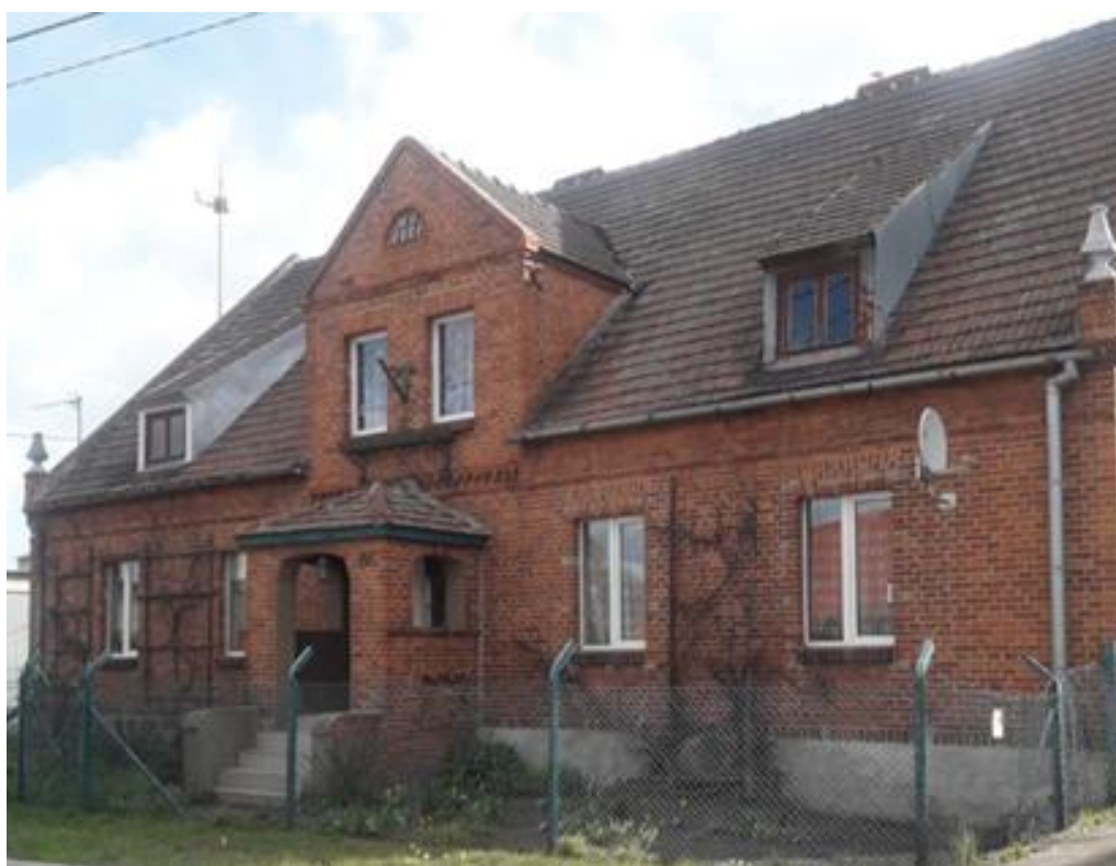
Budynek mieszkalny w Krotoszynie
