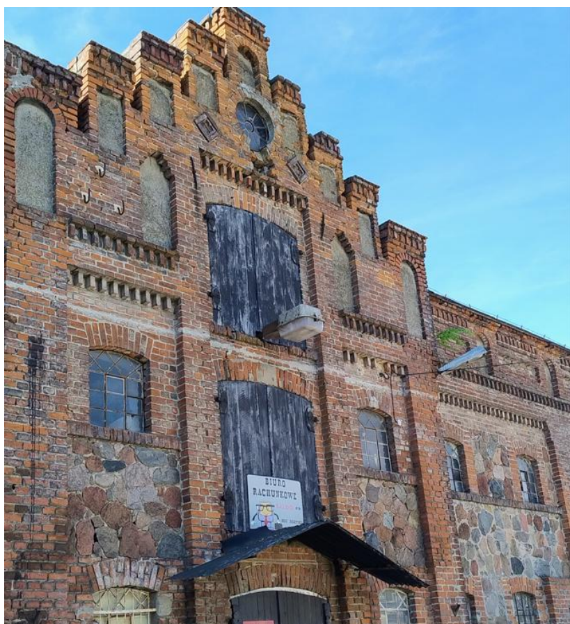
Budynek byłego magazynu zbożowego
