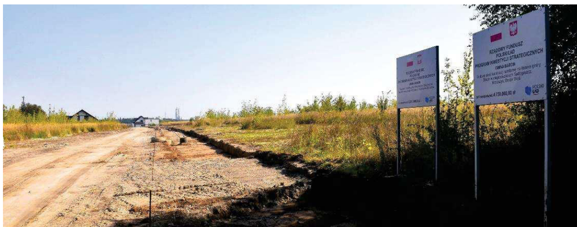
Budowa drogi w Krotoszynie
