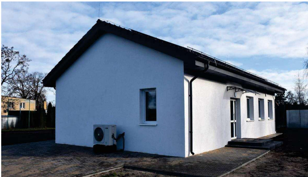
Nowa świetlica w Julianowie – Sołectwo Barcin Wieś
